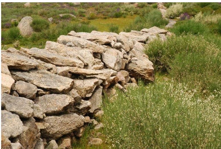
Figura 2 – Muro em pedra solta, provavelmente de proteção a antigos campos de cultivo de centeio (Unhais da Serra).
