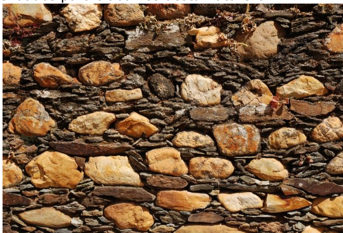
Figura 14 – Trabalhos em pedra.
